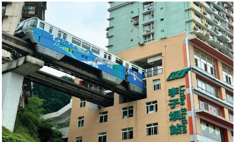
单轨李子坝站 Liziba Monorail Station
